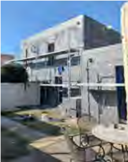
Réhabilitation de 50 villas « LES CAPITELLES » à LEUCATE
