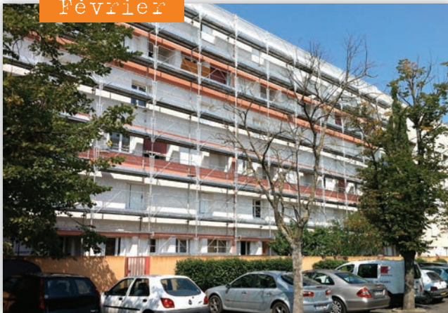
Lancement de la réhabilitation énergétique du Viguiers - Bâtiment Flandre
