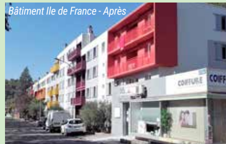
Bâtiment Ile de France - Après
