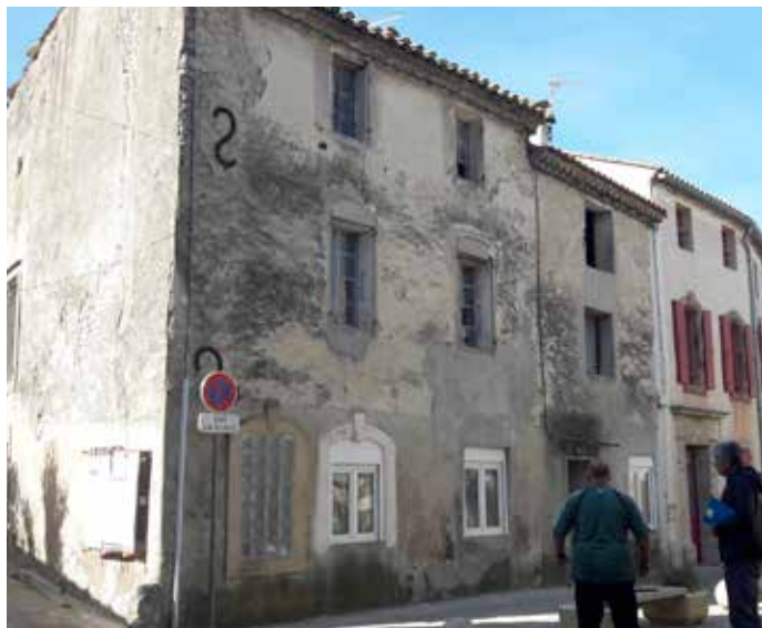
Marcorignan avant les travaux !
